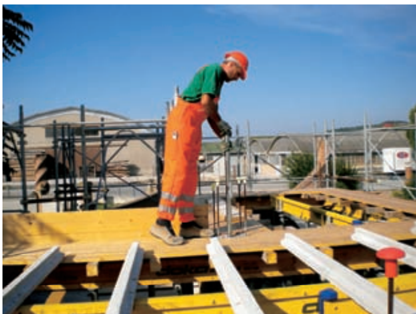
Figura 32 – Inserimento di un'asta nella boccola
