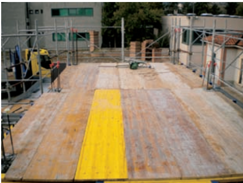
Figura 49 – Banchinaggio ultimato
